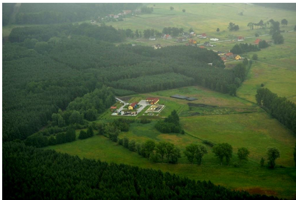
Rys. 31 Fotografia Oczyszczalni Ścieków w Szlichtyngowej. [Źródło: materiały Urzędu Miasta i Gminy w Szlichtyngowej]
